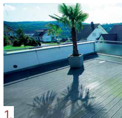
1. Terasa v pôvodnom stave
